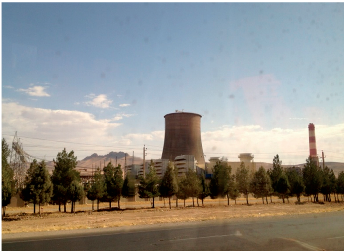
Imagen 6: Una de las múltiples centrales eléctricas en el distrito de Ahvaz, a unos 140 kilómetros al norte del golfo Pérsico
